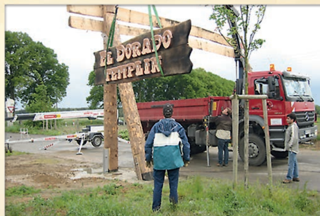
2006 - Bau Eingang B109
