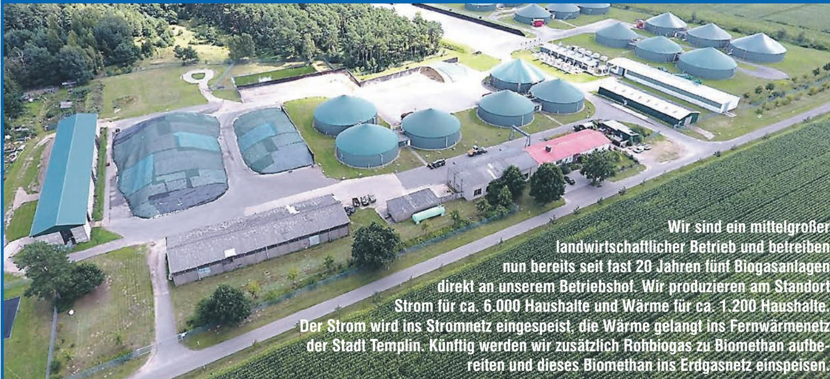
Wir sind ein mittelgroßer landwirtschaftlicher Betrieb und betreiben nun bereits seit fast 20 Jahren fünf Biogasanlagen direkt an unserem Betriebshof. Wir produzieren am Standort Strom für ca. 6.000 Haushalte und Wärme für ca. 1.200 Haushalte. Der Strom wird ins Stromnetz eingespeist, die Wärme gelangt ins Fernwärmenetz der Stadt Templin. Künftig werden wir zusätzlich Rohbiogas zu Biomethan aufbereiten und dieses Biomethan ins Erdgasnetz einspeisen.
