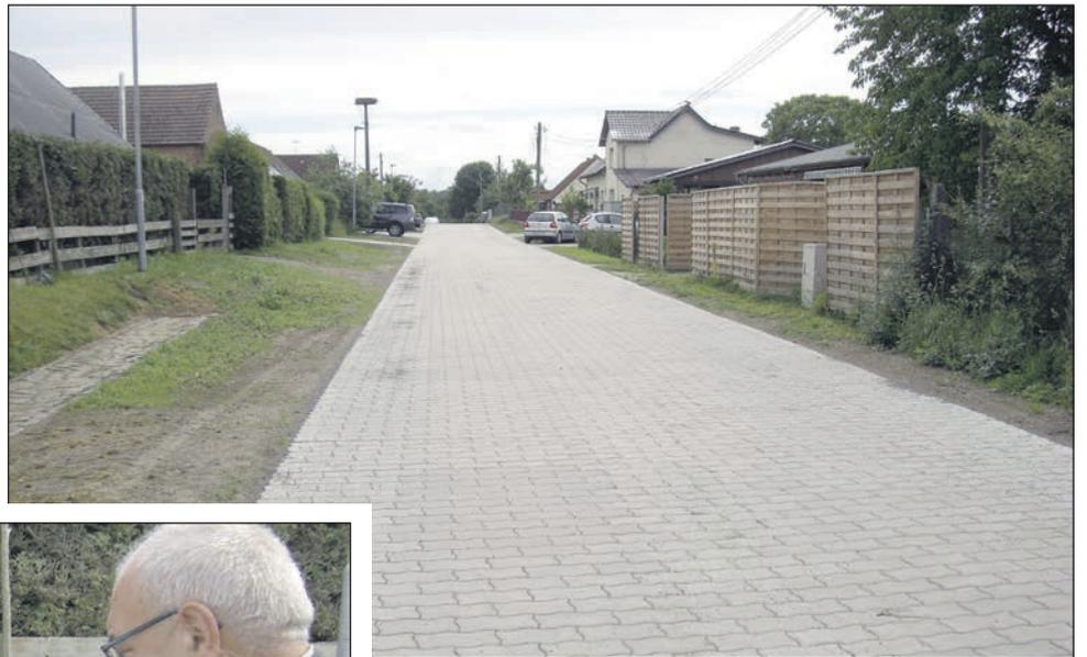
**Das neue Straßenstück ist nun 250 Meter lang und knapp 5 Meter breit. Belegt wurde es mit Betonstein-Verbundpflaster, welches speziell für den ländlichen Wegebau geeignetes ist.**
