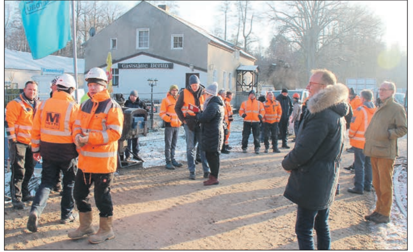
Kurz vor dem Jahreswechsel 2023 wurde Richtfest für das Betriebsgebäude der Schleuse gefeiert.
