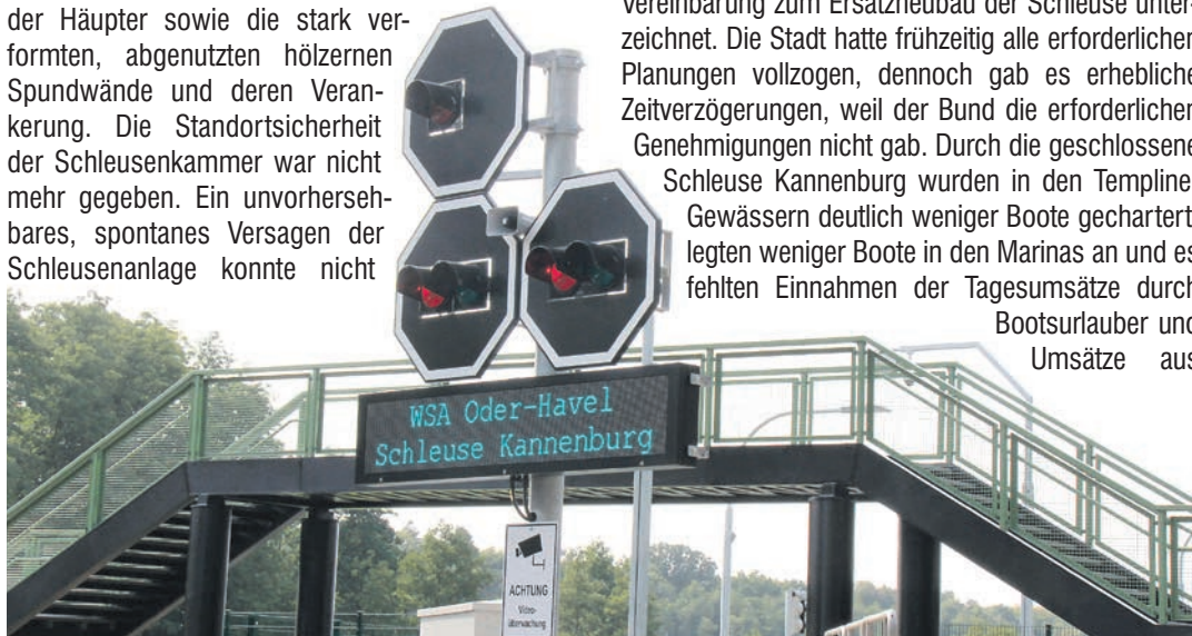
Über eine Fußgängerbrücke gelangen Wanderer und Radfahrer über den Schleusenkanal. Antirutschbeläge sichern nun ein einfacheres Passieren der Brücke für Radler.
