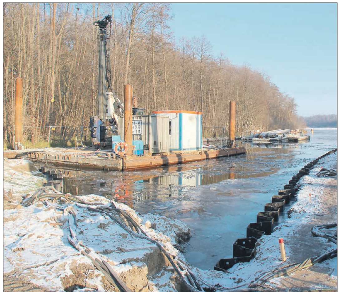
Trotz eisiger Temperaturen gehen die Bauarbeiten weiter.
