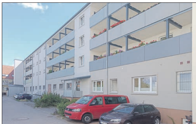
Aufzugsbau Am Markt 17
