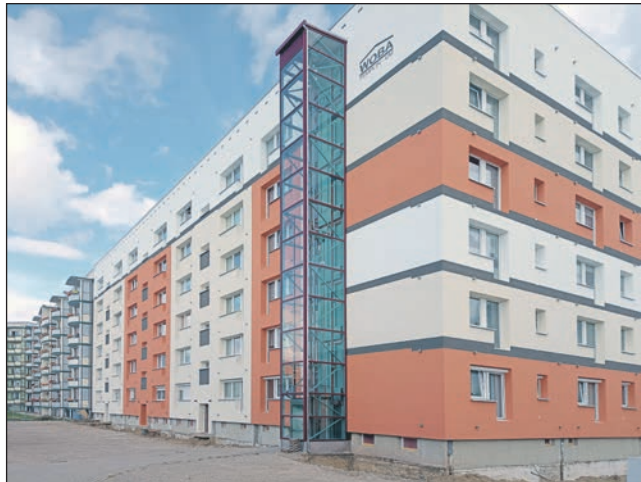
Balkonsanierung Straße der Jugend 1-4
