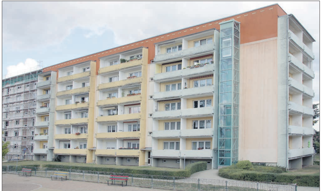
Aktueller Anblick der Balkone in der Straße der Jugend 1-4 vor der großen Baumaßnahme.
