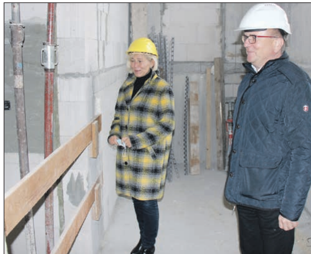
Die Geschäftsführerin der WOBA Templin, Dr. Anneli Jeschke-Kollár, ist mit dem Bauablauf sehr zufrieden. Es gäbe lediglich eine Woche Verzögerung, erklärt sie Bürgermeister Detlef Tabbert, der sich ein Bild vor Ort vom Baugeschehen machen wollte.
