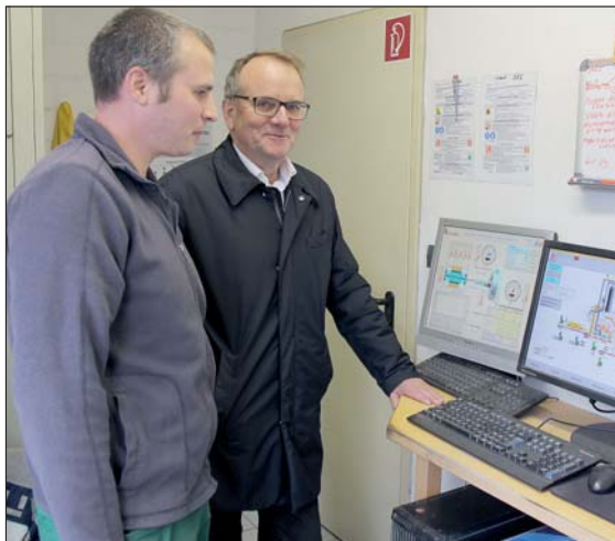
Detlef Tabbert informiert sich in der Schaltwarte des betriebseigenen Kraftwärmekopplungs-Kraftwerks, mit dem unabhängig Strom und Wärme erzeugt werden kann.
